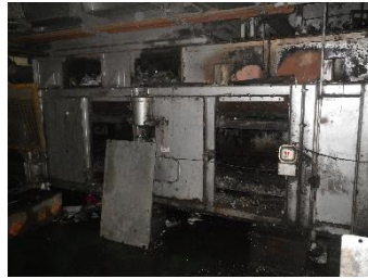
【焼損した搬送コンベア】
